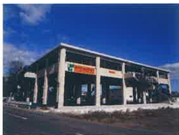
平成27年度から5か年計画で整備されている津波避難タワーの最後の1基となる「根倉・行部津波避難タワー」の建設工事が進められています。
